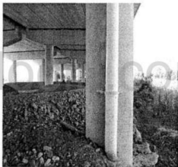
由桥墩而下的收集竖管
